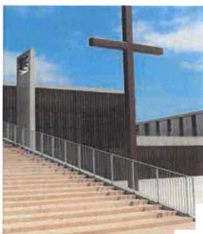
Obra: Construção de Igreja e Lar de Idosos Empreiteiro: ZUCOTEC Local: Porto Salvo - Oeiras Tipo de aplicação do ASIC: Enchimento e camada de sub-base e base
