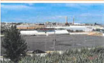
Proprietário: União Futebol Clube Moitense Empreiteiro: Obrísilma, Lda. Local: Moita Tipo de aplicação do ASIC: Aplicação de ASIC em camada de sub base e base para colocação de relvado sintético em campo de futebol de 11.
