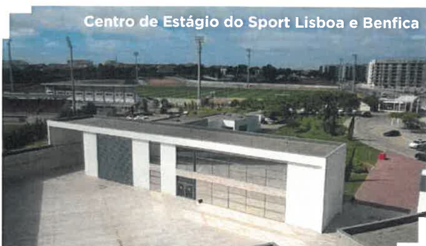
Empreiteiro: Gonçalo Buraca Engenharia Unipessoal Lda; Oliveira e Castim, Lda - Construção Civil e Obras Públicas.
