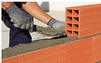
Aplicação da ALVENARIA ecoCORK
