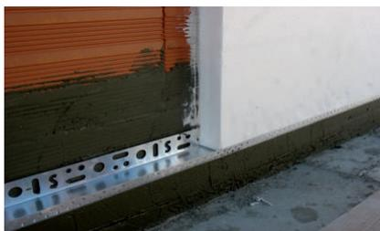
Aplicação das placas de EPS com perfil de arranque
