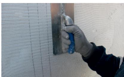
Aplicação da rede de fibra de vidro sobre **ADHERE Vit FibrasFLEX**
