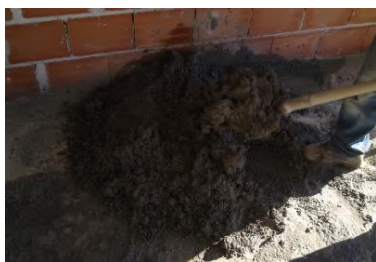
Colocação da argamassa
