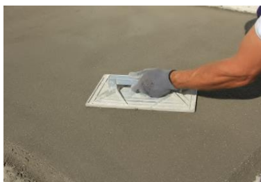
Regularização com régua metálica
