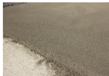
Talochamento da superfície final
