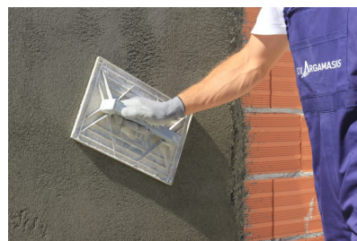
Talochamento da superfície final
