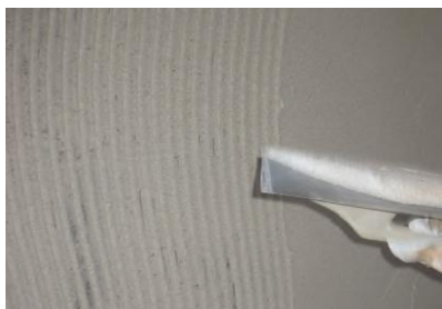
Primeira camada sobre o isolamento
