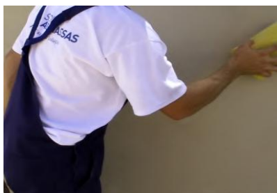
Acabamento areado com REABILITA Cal Acabamento
