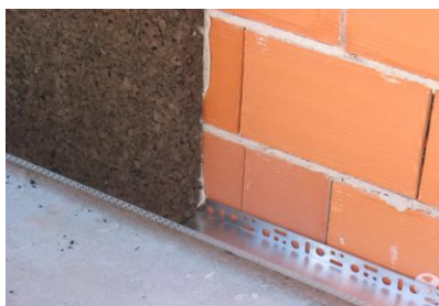
Aplicação painel de cortiça e perfil de arranque
