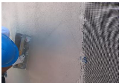
Execução da camada de regularização
